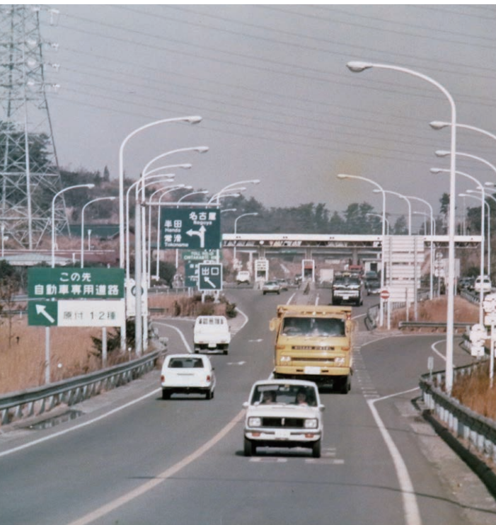
▲半田ICから大高方面を望む。料金所手前にある「この先自動車専用道路」の表示板は、南知多道路が道路法で「一般有料道路」と位置付けられていたことによるもの。南知多道路は知多半島道路より制限速度が速く、原付等の通行も可能だった。南知多道路が「自動車専用道路」に指定されたのは四車線化された平成11年で、このとき名実ともに知多半島道路と一体化した。(昭和49年頃か)※1
