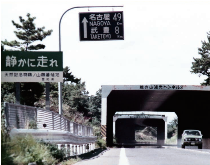
▲美浜ICの北に設けられた「鶯の山遮光トンネル」。手前の注意標識には「天然記念物 鶯ノ山鶯蕃殖地」の表示。(昭和49年)※1
